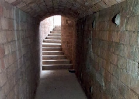
Escales d'entrada al refugi antiaeri
