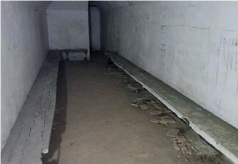
Una de les sales del refugi, amb els bancs encofrats
