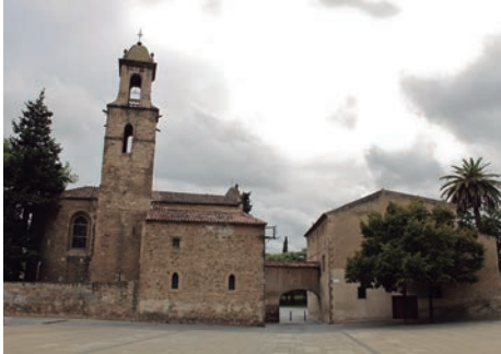
Església i rectoria de Sant Martí de Provençals. Font fotografia: Viquipèdia.
